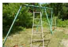
遊具の設置・修繕
