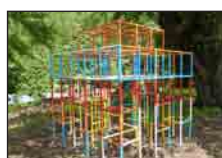
遊具の設置・修繕
